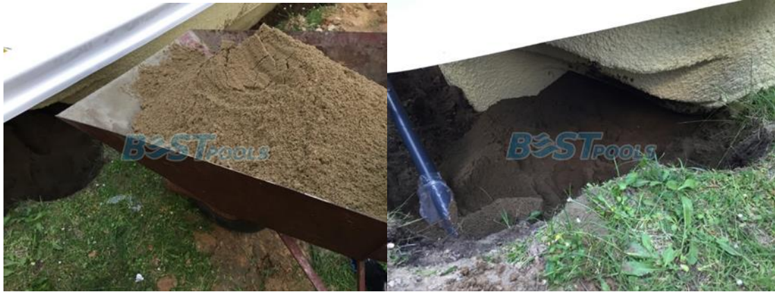
Trappan fylls underifrån
