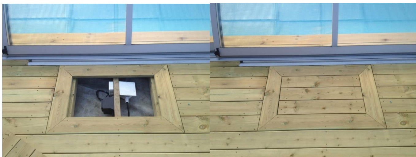
Inspektionslucka av & på
